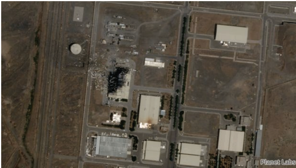
موقع الحريق في منشأة نطنز (المصدر: بي بي سي الفارسي)
